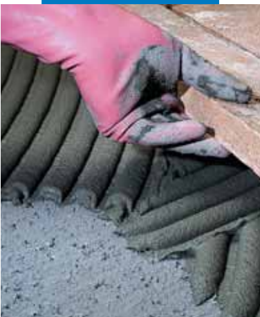
Укладка терракоты на ровное основание
