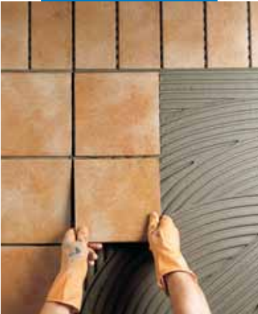
Укладка клинкерной плитки снаружи помещений
